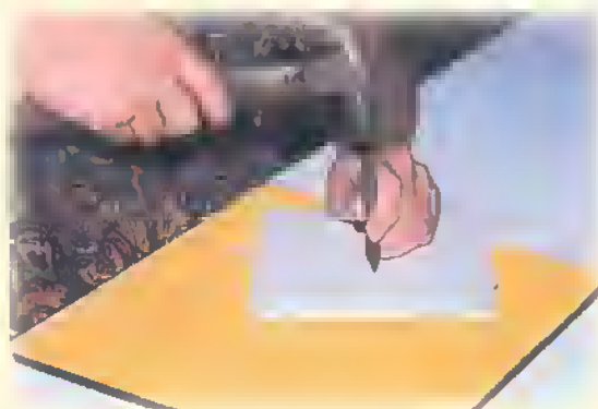
Figura 8.19. Plantilla con fotocopia para marcar las perforaciones
